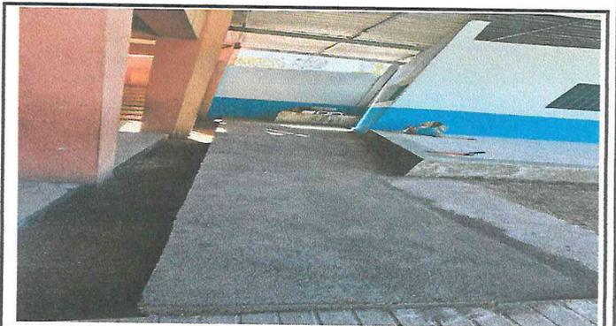
Foto 4: FUNDICION DE LOSA EN GRADA DE PATIO
