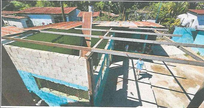
Foto 1: SUSTITUCION DE ESTRUCTURA DE METAL Y LAMINA EN TECHO DE AULA, COCINA Y CORREDOR
